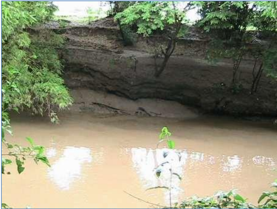
Figura 03 – Erosão marginal. Rio Jacarecica, Campo 2009
