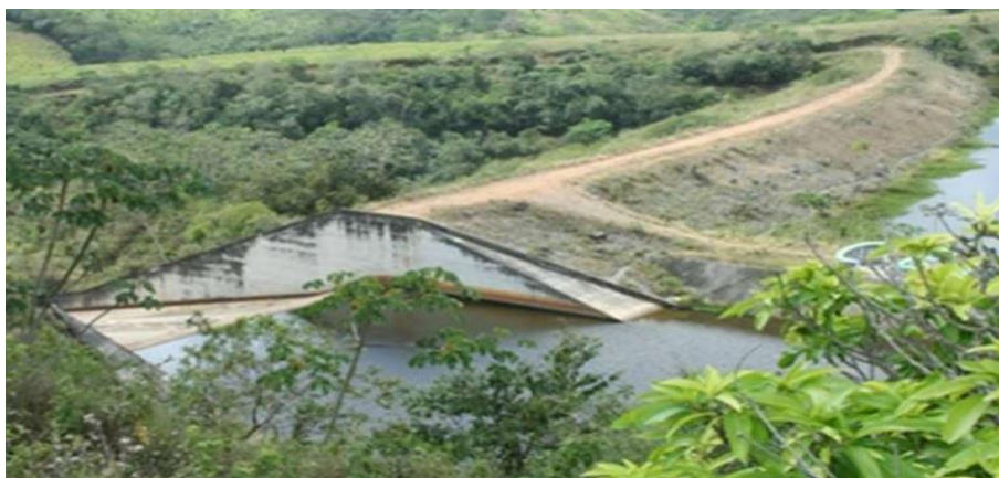
Figura 2: Barragem do Jacarecica II.
