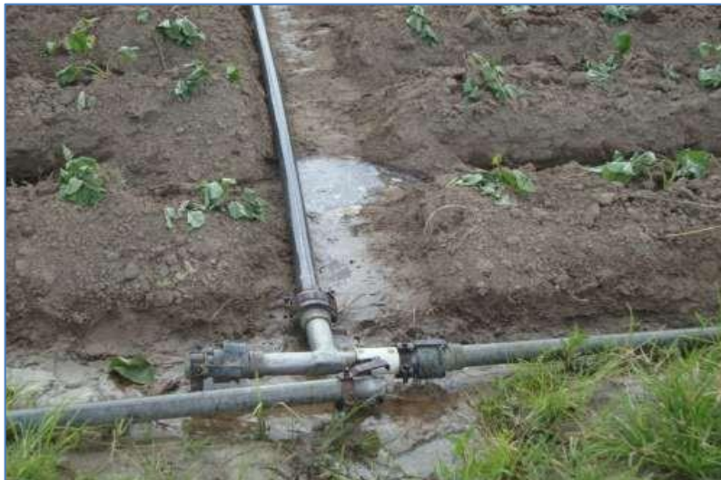
Figura 7. Vazamentos nas conexões de engate rápido com a linha lateral.
