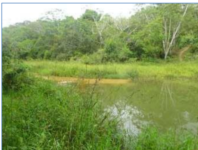
Figura 6 - Estação de captação de água-Malhador
