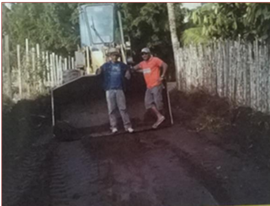
Figura 6: Terraplanagem Comunidade Mamuriacá Nhamundá/AM
