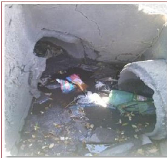
Figura 16: Ligação de esgoto na rede de drenagem no bairro Centro
