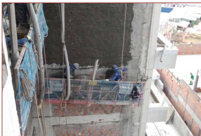
Figura 6: Atividade em andaime suspenso.
