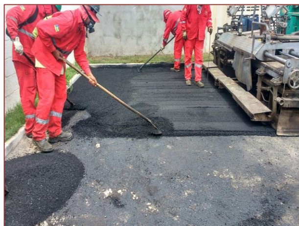
Figura 8: Uso dos Epi's em atividade de pavimentação.
