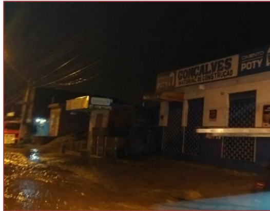
Figura 15: Ponto de alagamento no bairro Cidade Nova
