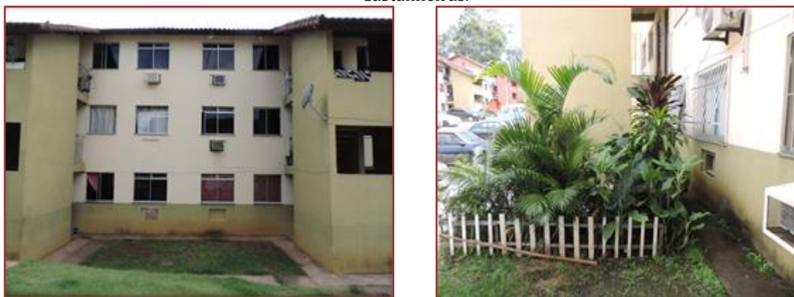
Figuras 6 e 7 – Aspectos construtivos e espaços públicos entre os edifícios do Condomínio Vivenda das Castanheiras.
