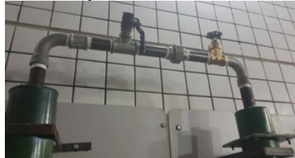
Figura 9: Saída para tomada de amostra do gás.
