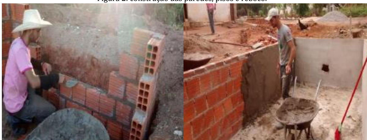
Figura 2: construção das paredes, pisos e reboco.
