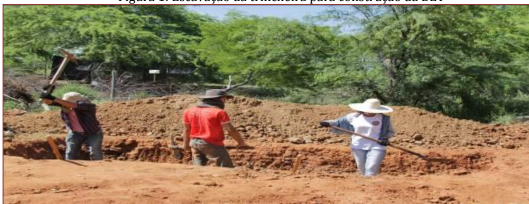
Figura 1: Escavação da trincheira para construção da BET
