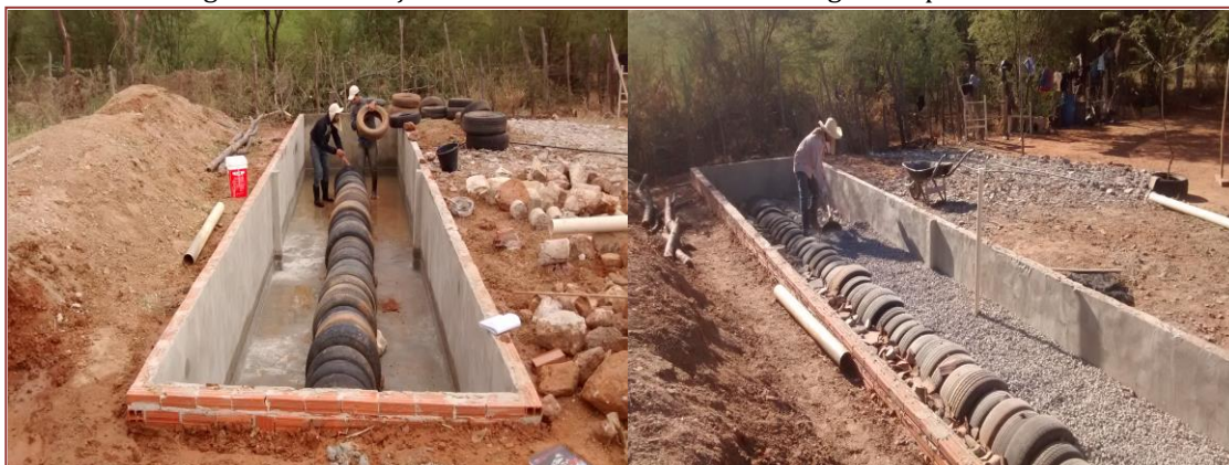
Figura 3: construção da câmara anaeróbica e montagem da primeira camada.
