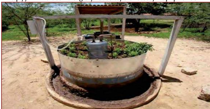
Figura 1. Biodigestor sertanejo construído no nordeste brasileiro. Fonte: Mattos, L. C., & Farias, M. J. (2011). Manual do biodigestor sertanejo. Projeto Dom Helder Camara. 55p. Recuperado de http://www.diaconia.org.br/novosite/biblioteca/int.php?id=53
