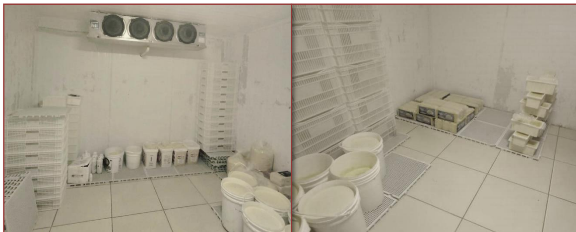
Figura 5: Câmara fria para armazenar os queijos produzidos pela fabriqueta
