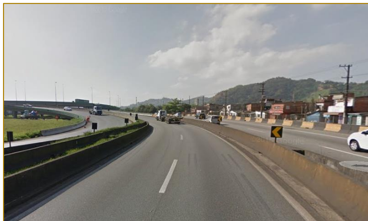
Figura 4 - Viaduto de Acesso a perimetral de Santos
