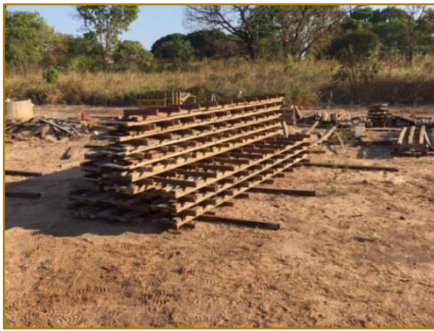
Figura 5 – Ferro para vigas
