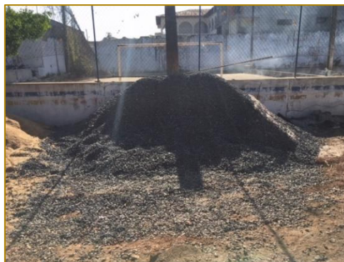
Figura 1 – Brita acondicionada sem baia de retenção
