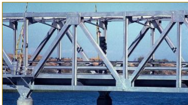
Figura 3 – Ponte do tipo Warren modificada
