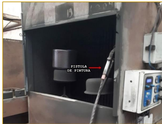
Figura 4: Cabine de pintura e pistola.
