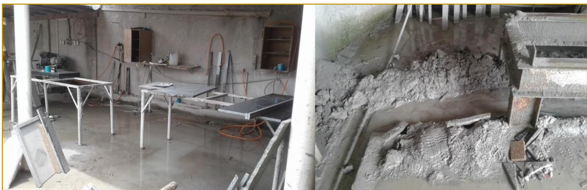
Figura 03: Umidade excessiva no ambiente de trabalho
