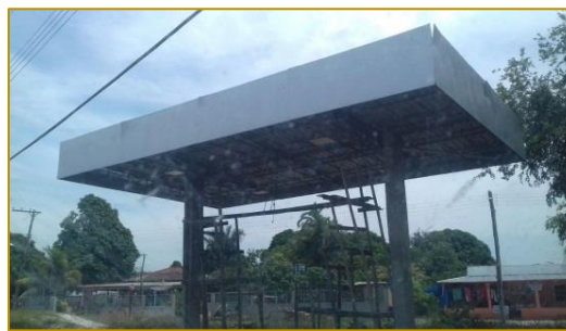
Figura 06 – Posto de gasolina em construção
