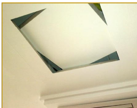
Figura 5 – Alçapão instalado
