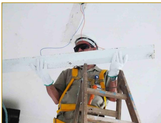
Figura 51 – Substituição das lâmpadas do hall de acesso
