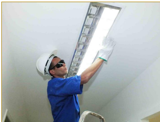
Figura 10 – Substituição das lâmpadas no corredor
