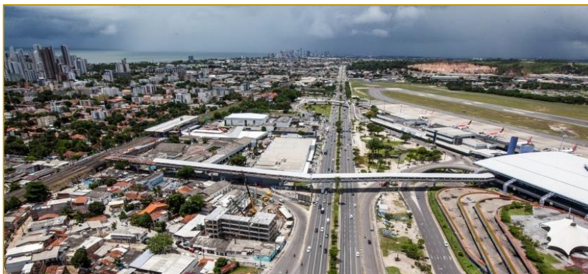
Figura 5 - Passarela de ligação do aeroporto para o metrô
