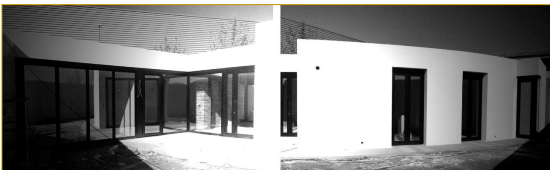
Figura 6. Fachada interior -sur-. En construcción.
