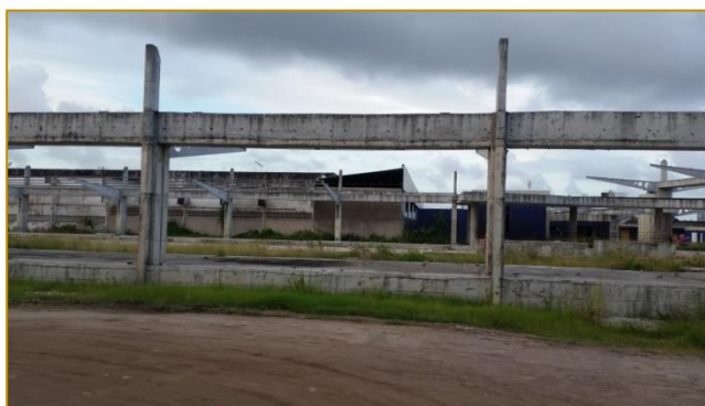
Figura 4 - Estação Integração Da Caxangá – Recife-Pe
