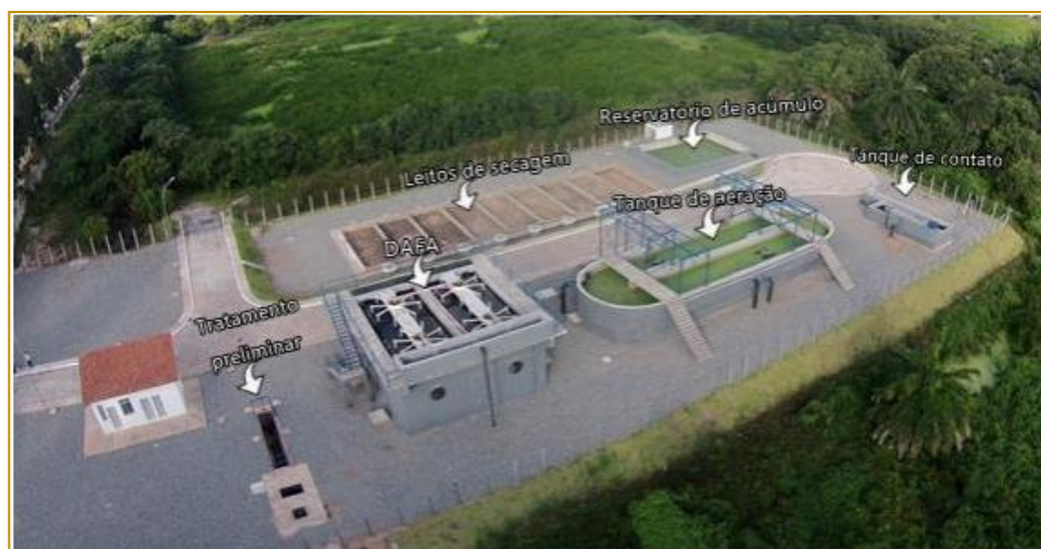
Figura 1 – Estação de tratamento de esgotos UFS
